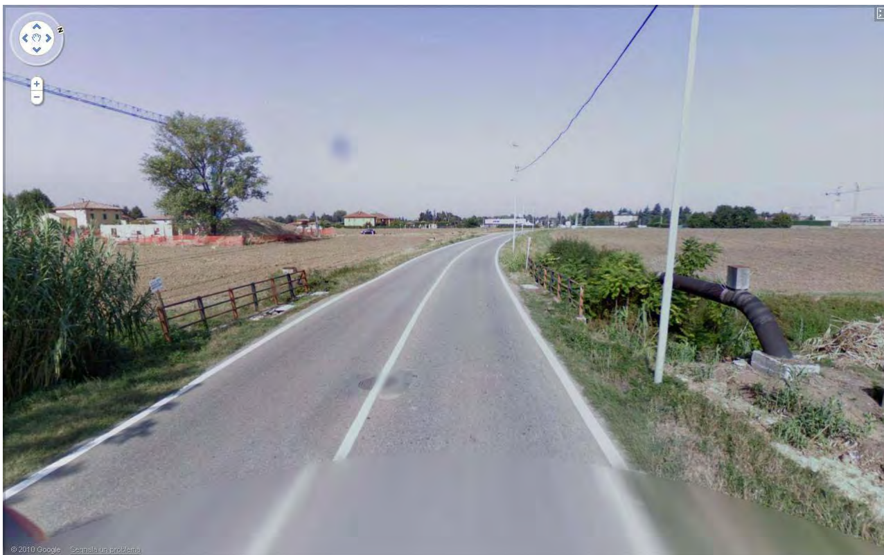
Via Bertolazzi/Frullo – ponte sullo scolo Zenetta - vista verso via S.Donato
