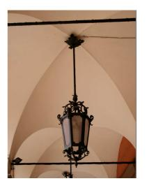
Negli anni più recenti sono state montate luci al sodio lungo le catene longitudinali, in grado di illuminare sia il percorso pedonale protetto che la strada attigua.
